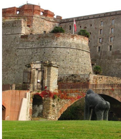
Fig. 4- Ingresso della Fortezza del Priamar con l'installazione di fine 2015
