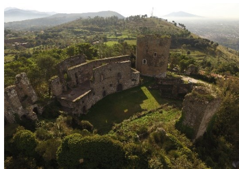
Fig. 1- Immagine aerea del complesso fortificato
