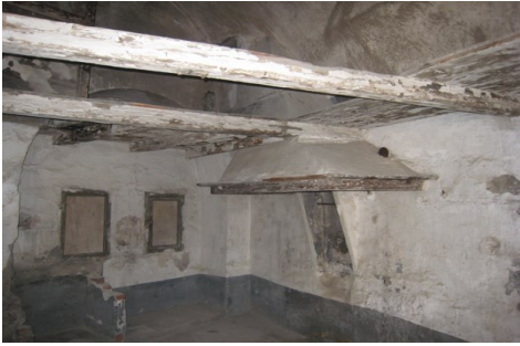
Fig. 4- Forte di Exilles, corpo di fabbrica del "Cavaliere", camerone di guardia, prima dell'intervento di restauro (2005)
