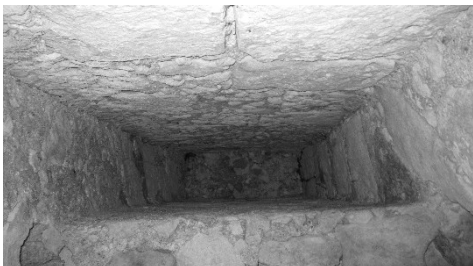
Fig. 14- Locale voltato nell'area dell'ex Caserma: apertura per la ventilazione
