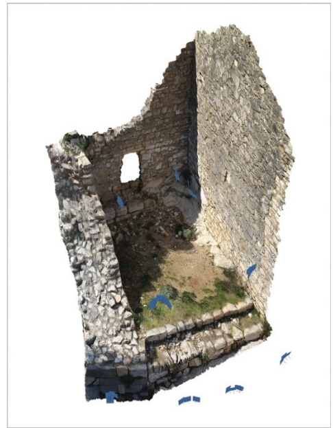
Fig. 5- Metodo di acquisizione per il rilievo fotogrammetrico a terra
