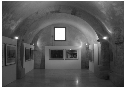
Fig. 6- Cannoniera a protezione del settore nord/ovest delle fortificazioni del quartiere Castello
