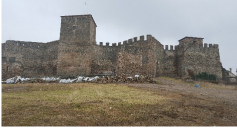
Fig. 3- Eptapyrgio , Salonicco. Fronte esterno est vista generale
