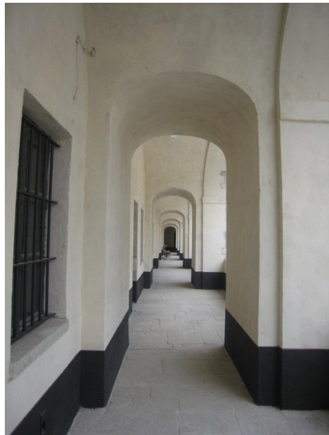
Fig. 6- Forte di Exilles, corpo di fabbrica del "Cavaliere", il loggiato dopo l'intervento conservativo (2008)
