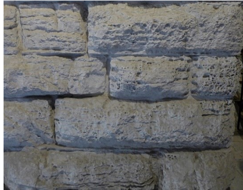
Fig. 3- La torre difensiva in opera pseudoisodoma di epoca tardo repubblicana
