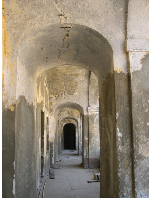
Fig. 5- Forte di Exilles, corpo di fabbrica del "Cavaliere", loggiato antistante le camerate degli ufficiali, prima dell'intervento di restauro (2005)
