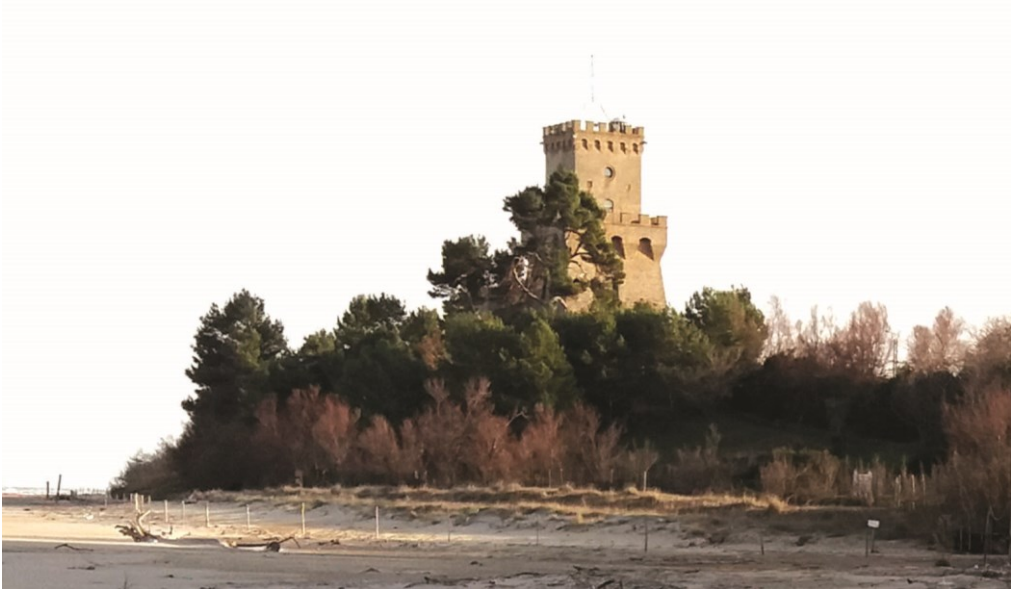
Fig. 1- La Torre di Cerrano, lato costa-nord (foto ottobre 2017)
