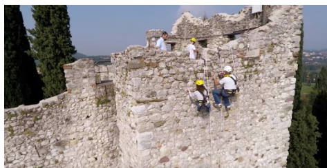
Fig. 7- Castello di Soiano del lago, Verifica dei lavori da eseguire
