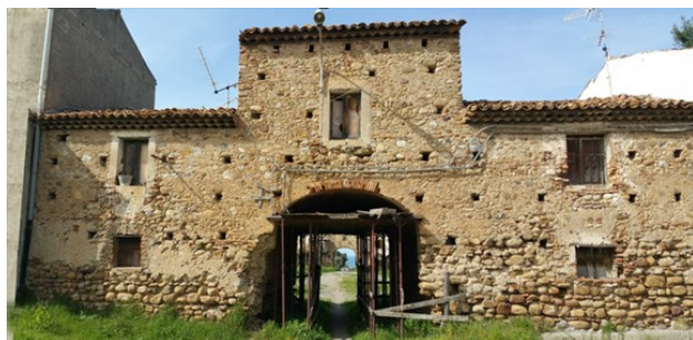
Fig. 9- Facciata con arcata e suo degrado
