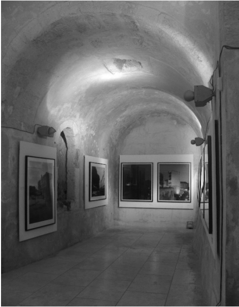
Fig. 7- Passaggio voltato in comunicazione -oggi a meno di una parete in muratura- con la chiesa cinquecentesca di Santa Maria del Monte. L'intradosso della volta a botte mostra la conservazione di una apertura funzionale alla ventilazione dei locali
