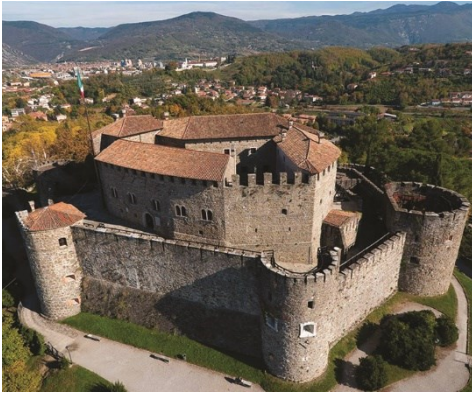
Fig. 2- Vista complessiva del castello con la cinta interna e torrioni
