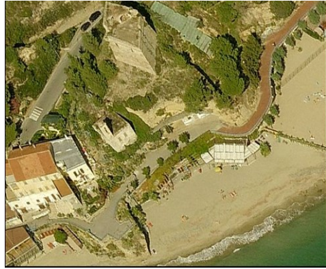
Fig. 1- Vista aerea del complesso.
