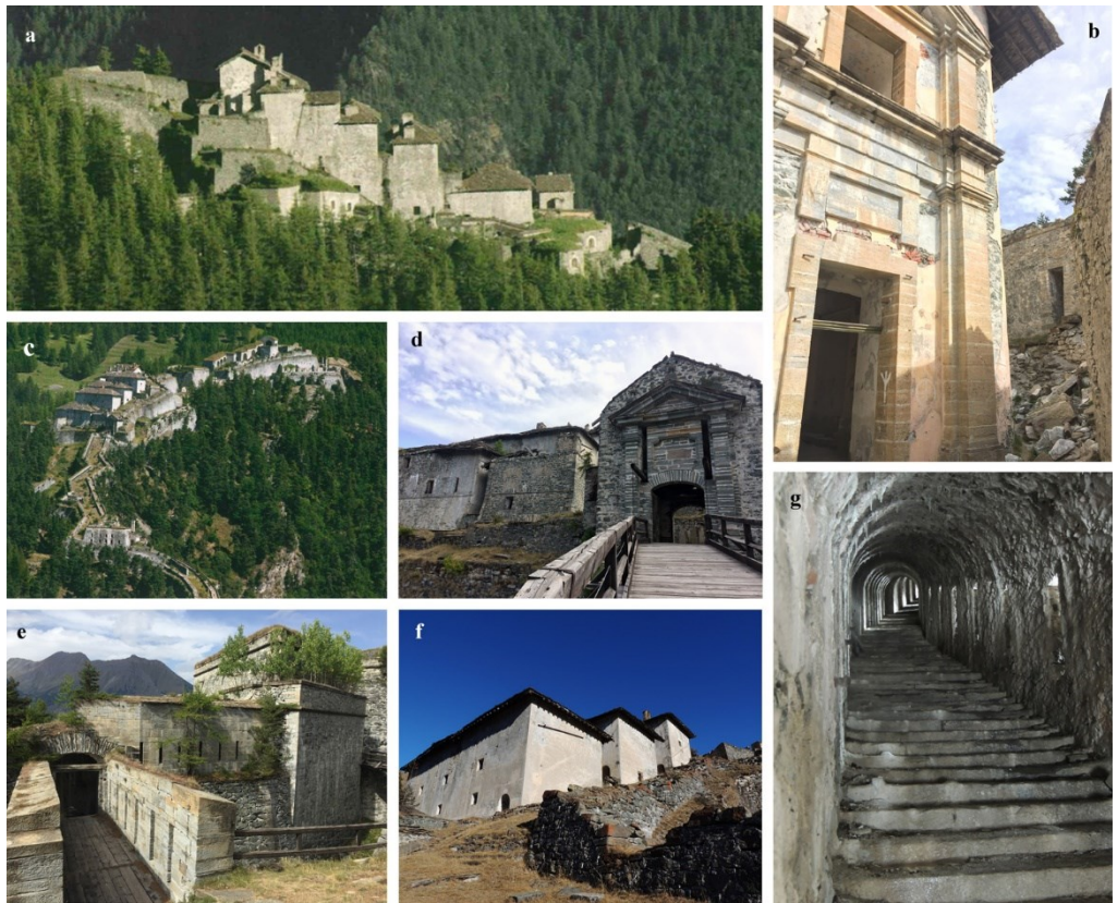
Fig. 5- La Ridotta Belvedere: a. Prospetto Nord-Ovest; b. Cappella; c. Sviluppo del Forte delle Valli visto da Sud-Ovest; d. Porta Reale, oggi raggiungibile attraverso un ponte di legno; e. Muraglie della Ridotta; f. Quartieri di casermaggio; g. Scala coperta. (Archivio storico fotografico dell'Associazione Progetto San Carlo, Forte di Fenestrelle, ONLUS).
