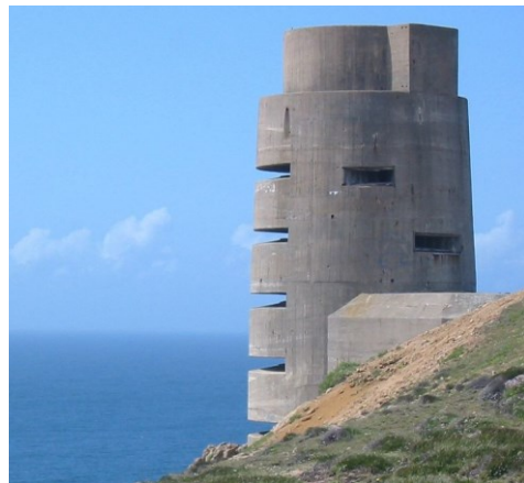
Fig. 2-. Búnker-torre observatorio del Atlantic Wall en Jersey, Channel Islands (Internet, 2017)
