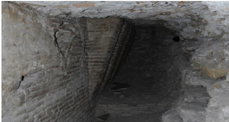
Fig. 4- Cortine laterizie a piombo con beccatelli, ritrovate nel corso dei lavori di restauro
