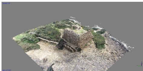
Fig. 7- Torre Vigliena. Point Cloud
