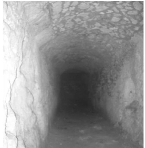
Fig. 15- Tunnel voltato conservato nei sotterranei della Scuola di Architettura
