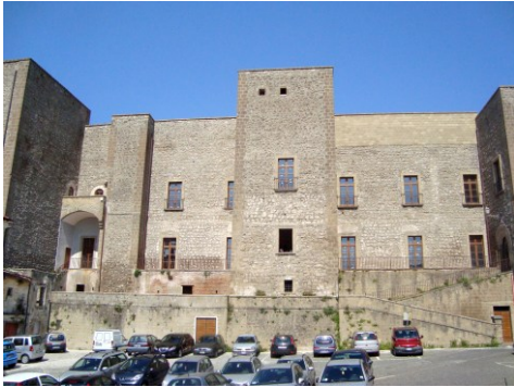
Fig. 3- Facciata est su piazza castello
