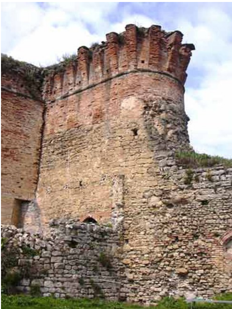
Fig. 5- "Saliente" del "2° girone", apparato a sporgere (Archivio Taddei, 2012)
