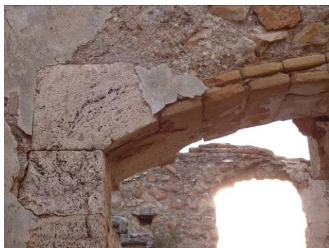
Fig. 6- Vano de sillería con capialzado de ladrillo tabicado (García Sáez, 2018)
