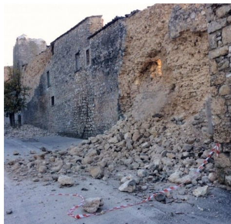
Fig. 2- Particolare della cinta muraria, lato nord
