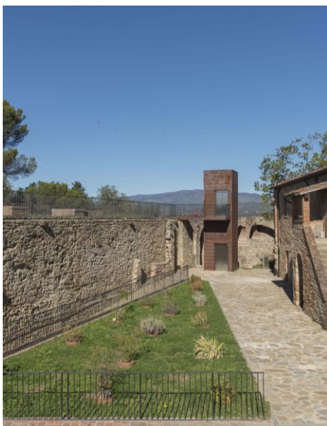
Fig. 3- Vista del nuovo sistema di risalita (Ciampi, 2017)
