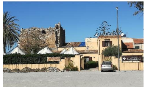
Fig. 10- Termini Imerese (PA), torre Battilmano
