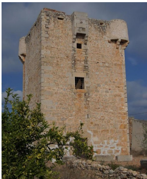
Fig. 10- Torre defensiva del Carmelet. Cabanes (Foto: Google)
