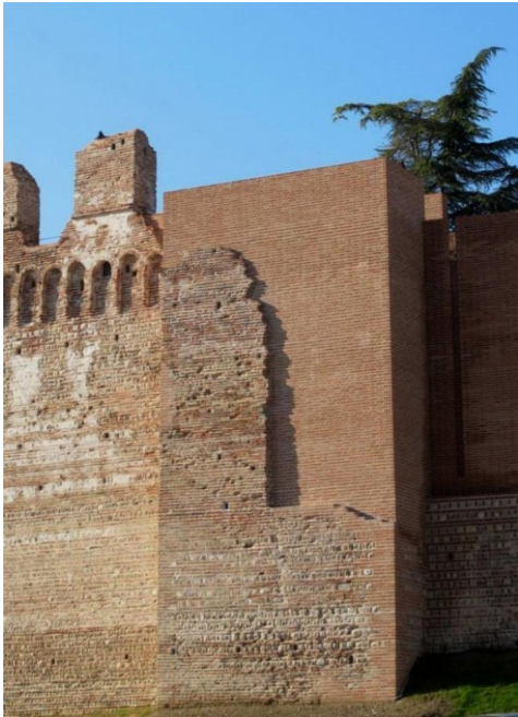
Fig. 4- Cittadella (Padova). Reintegrazione muraria (P. Valle, 2005-2013)
