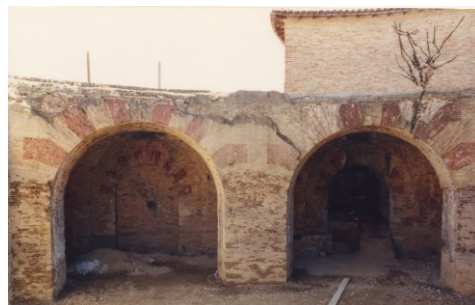
Fig. 8- Galleria anulare, rubricature delle arcate costituite da conci in mattoni rossi e gialli
