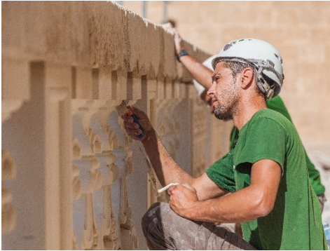
Fig. 8- Intervento sulla balconata (2014)
