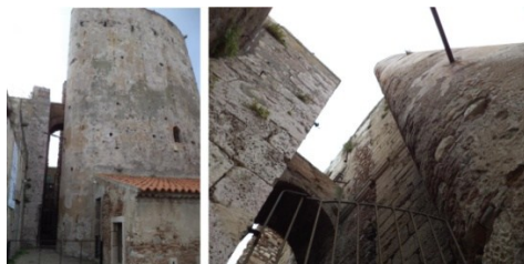
Fig. 6- La torre oggi. Si notano i resti di una torre precedente (a sinistra) antistante la seconda di pianta quadrangolare (a destra), alla quale è stata aggiunta una camicia protettiva semicircolare culminante con due arrotondamenti laterali a guisa di orecchioni (immagine Donato)
