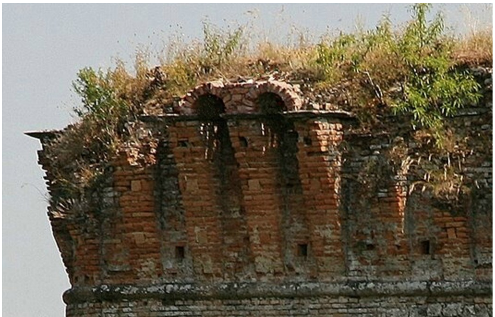
Fig. 9- Apparato a sporgere del “2° girone”. Particolare dei due archetti rimasti nel “Saliente” (Archivio Taddei, 2012)
