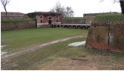
Fig. 3- Cittadella di Alessandria, Ponte della Porta Reale (foto di Guido Ratti, 2017)
