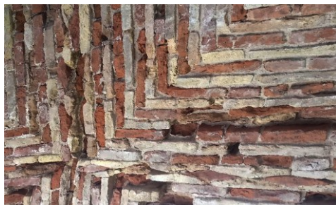
Fig. 6- Volta a crociera di accesso alla piazza bassa, file ortogonali di mattoni a losanga
