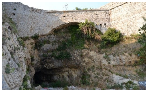
Fig. 10- Dulcigno, Montenegro, vista della murazione meridionale
