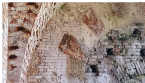
Fig. 10- Intersezione delle volte a crociera e ingresso alla piazza bassa a mare occultato
