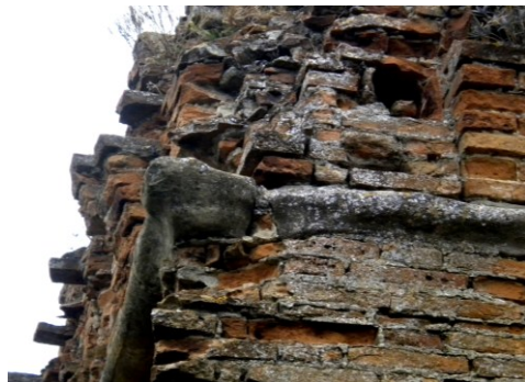
Fig. 7- Particolare dello spigolo della "Porta d'accesso", apparato a sporgere del "2° girone" (Archivio Taddei, 2012)
