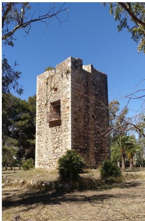
Fig. 5- Estado actual. Vista desde el Norte (Foto: J. Prior, 2018)
