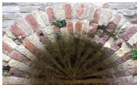
Fig. 9- Nicchia semicircolare, successione di mattoni arrotondati e rastremati a raggiera
