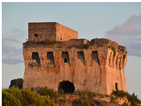
Fig. 2- Torre di Fiuzzi - Praia a Mare
