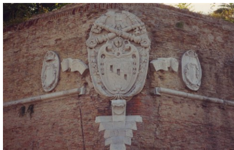
Fig. 5- Angolo esterno del bastione, sottosquadro a "V" con apparato decorativo
