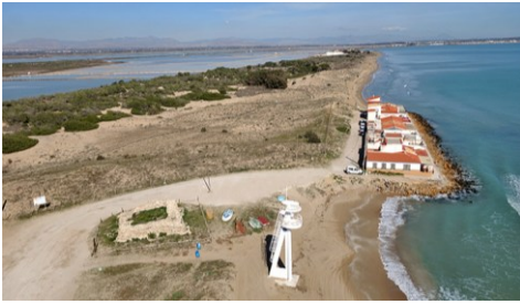
Fig. 3- Estado actual de la torre del Pinet (Rodríguez-Navarro)
