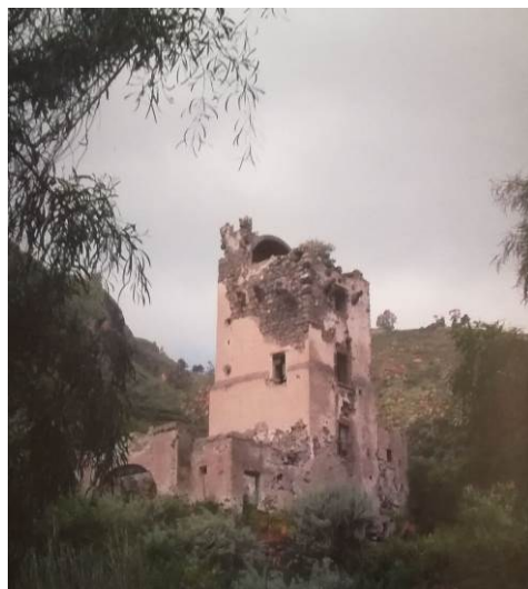
Fig. 13- Lipari (ME), torre Mendolita prima e dopo il recente intervento (Fresina, Maurici & Militello, 2008)
