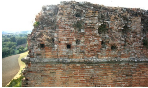
Fig. 6- "Porta d'accesso" del "2° girone", apparato a sporgere (Archivio Taddei, 2012)
