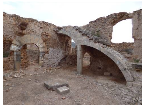
Fig. 3- Escalera sobre arcos rampantes en el patio central del castillo (García Sáez, 2016)
