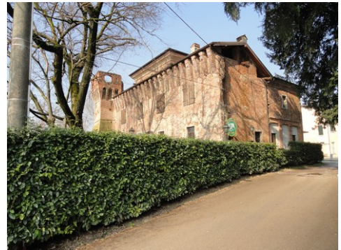
Fig. 6- Castello di Barco di Orzinuovi (Bs)
