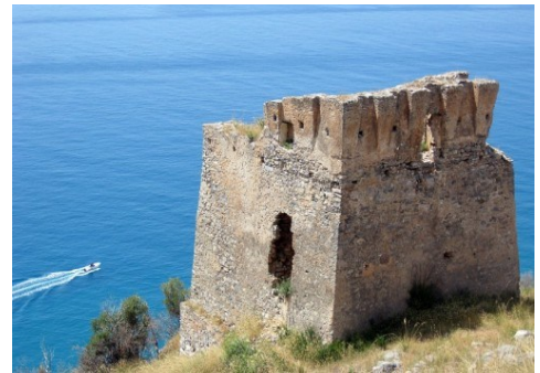
Fig. 6- Torre di Rienzo - Cetraro
