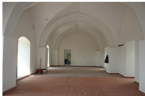
Fig. °7- Ambienti a piano terra durante i lavori
