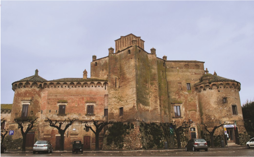
Fig. 12- Veduta d’insieme del prospetto est (2016)
