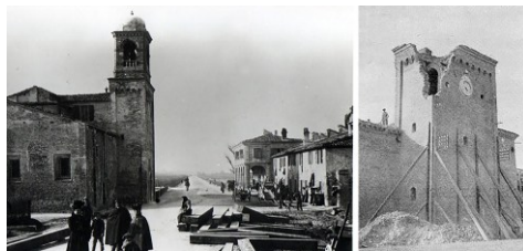
Fig. 12- Santuario della Madonna del Ponte, con torre a campanile prima nel 1930 (Baviera, fine 1800-primi del 1900) (a sinistra) e Danni del terremoto del 1930 (Fondo Archivio Storico Comunale, 1931) (a destra)
