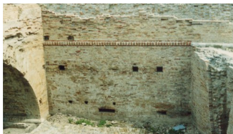
Fig. 7- Prospetto interno a nord, decorazione di mattoni in aggetto posati in taglio
