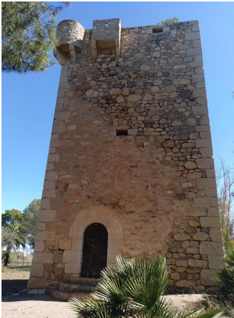
Fig. 1- Vista exterior del acceso -Alzado Sureste- de la Torre de la Sal en la actualidad (Cabanes) (Foto: J. Prior, 2018)
