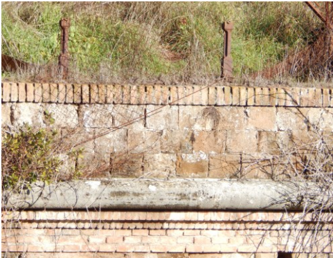
Fig. 4 – La cornice sommitale sui ricoveri
