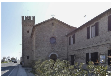
Fig. 13- Stato attuale del Santuario della Madonna al Ponte. Fronte Nord con accesso alla chiesa (Giansanti, Formaglini, Giraudeau & Giacomelli, 2018)
