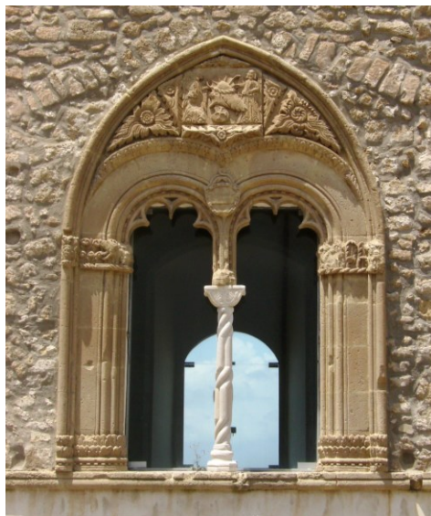
Fig. 9- Particolare della finestra catalana del cortile dopo il restauro
