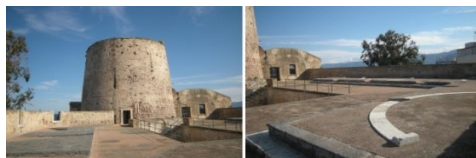
Fig. 4- La gola della torre vista dal fortino che la protegge da sud, aggiunto dopo il 1823 e dotato di due diverse tipologie di batterie di artiglieria (immagine Donato)
