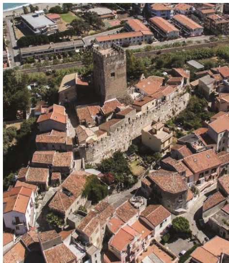
Fig. 1- Veduta aerea del castello di Brolo
