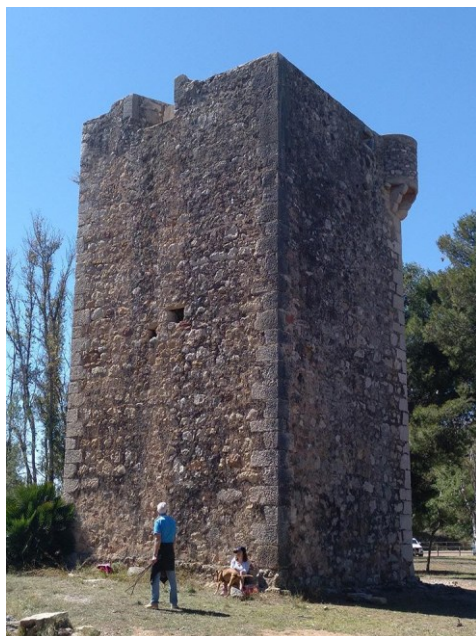
Fig. 6- Estado actual. Vistas desde el Oeste (Foto: J. Prior, 2018)
