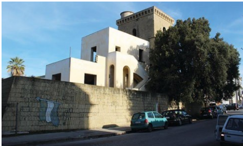
Fig. 9- Stato attuale, ripresa da Sud-Ovest
