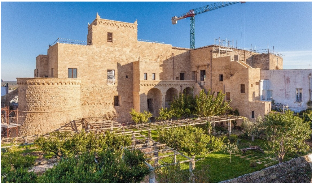
Fig. 5- Vista del castello da Ovest –in primo piano il giardino e la torre aragonese (2016)
