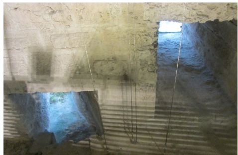
Fig. 12- Postazioni per bombarda affiancate e senza possibilità di brandeggio. Queste artiglierie, in particolare, divengono funzionali al tiro radente nel fianco ovest della tenaglia realizzata dal Capellino, come si osserva in Fig. 3
