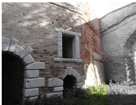
Fig. 8- dettaglio dell'appoggio delle strutture sanmicheliane alla torre del Castel Novo , visibile al centro
