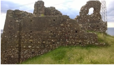
Fig. 6- Veduta lato nord (foto autografa, 2015)
