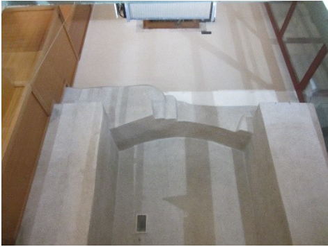
Fig. 8- Strutture storiche del baluardo Dusay interessate da restauri recenti
