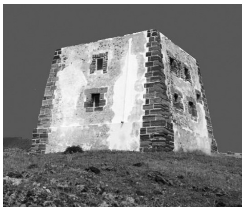
Fig. 8- La torre dello Spalmadore
