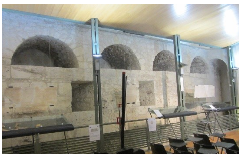
Fig. 14- Aperture per artiglieria presenti all'interno dei locali del baluardo Dusay (settore 2 fig.2). Si distinguono con chiarezza le due fasi costruttive legate alla trasformazione cinquecentesca attuata dai Palerari con l'elevazione dell'intero corpo di fabbrica
