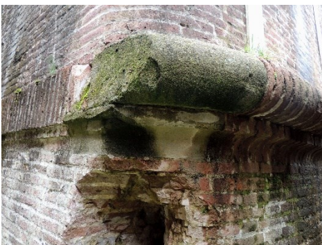
Fig. 6- Elemento architettonico in Pietra Serena
