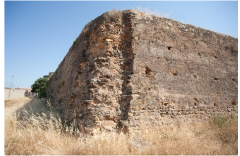
Fig. 6- Baluarte noreste de la fortificación de Traiguera. Foto del autor (2017).
