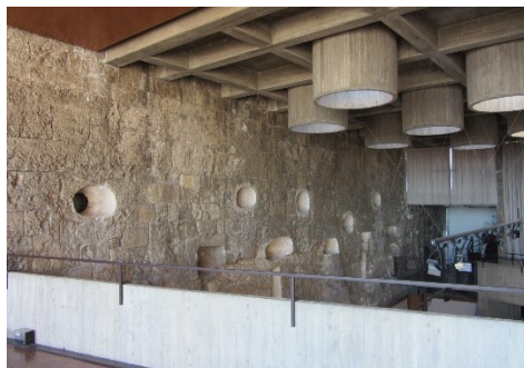
Fig. 16- Parete nord del baluardo Dusay prospiciente l'antico fossato. Si osserva la sequenza di bocche da fuoco disposte a più altezze
