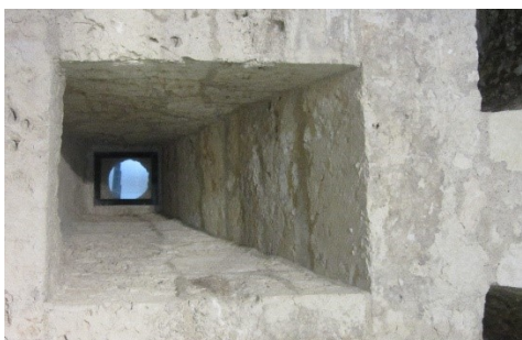
Fig. 15- Dettaglio dell'apertura per artiglieria (settore 2 Fig. 2)
