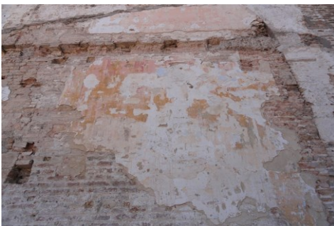
Fig. 13- Particolare del tamponamento dell'arco sul lato nord in mattoni gotici rivestiti
