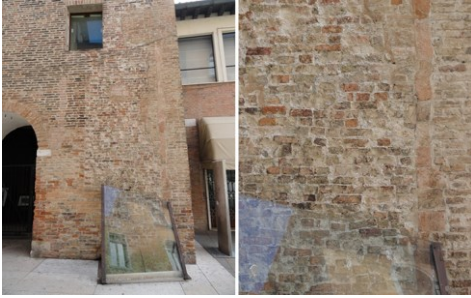
Figg. 12a-b- Interfaccia di demolizione della cortina muraria in altinelle sul lato ovest. La differenza dimensionale e il nesso stratigrafico di appoggio della cortina alla torre rafforzano l'ipotesi storiografica che la cinta muraria sia frutto di un'aggiunta, forse avvenuta dopo la conquista veneziana del 1337.
