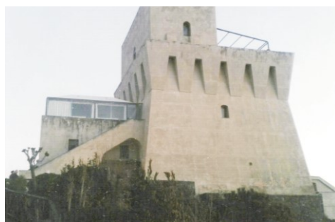
Fig. 4- Torre del Greco, Torre Bassana
