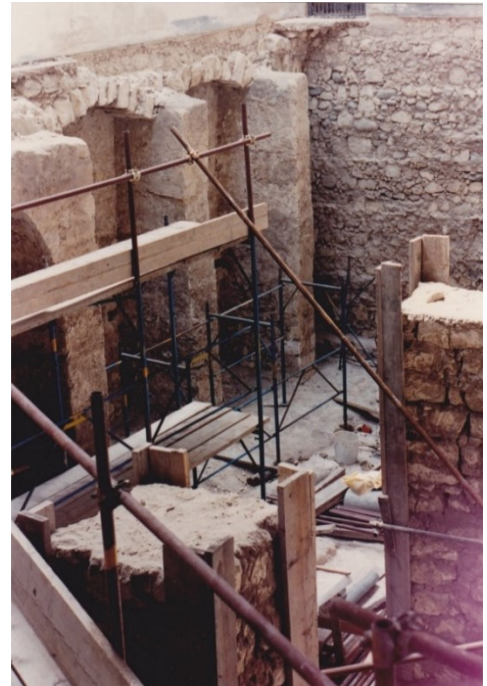
Fig. 7- Strutture presenti all'interno del baluardo Dusay (In AS-BAPSAE CA-OR, Cartella Cagliari, Complesso di San Pancrazio, perizia 33/92, del 10 agosto 1992; immagine pubblicata all'interno della tesi di Laurea di M. Loddo, 2011). Le strutture vengono poste in essere al fine di terraplenar il baluardo e consentire l'alloggio di artiglierie pesanti in posizione di “cavaliere”
