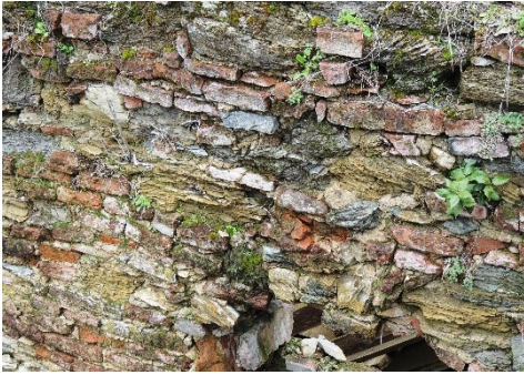
Fig. 4- Il nucleo delle murature in conci di "galestro" e laterizi
