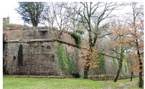
Fig. 3- Il paramento in laterizio della Fortezza
