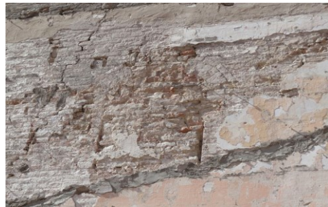
Fig. 14- Finestra ad arco bardellonato ricavata in rottura nell'ogiva della porta urbana e nel relativo tamponamento
