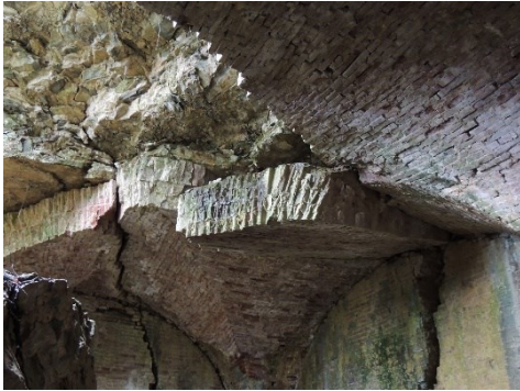
Fig. 8- Un esempio del sistema costruttivo utilizzato nella realizzazione delle volte degli ambienti monumentali nel corso XVI secolo
