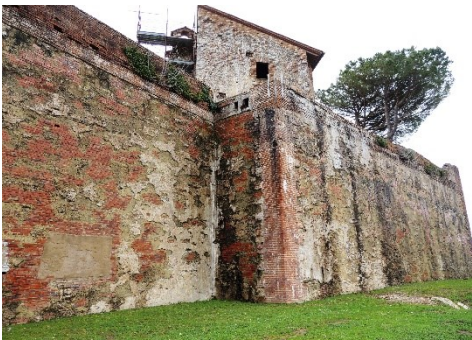
Fig. 5- Il mastio con i resti dell'intonaco originale
