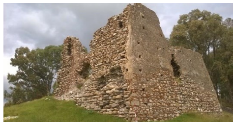
Fig. 5- Veduta angolo Sud-est (foto autografa, 2015)
